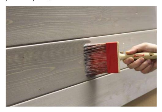
Сушка второго слоя Pullex Silverwood 12 час при температуре 20°C. Высокая влажность и /или низкие температуры замедляют процесс высыхания и увеличивают время сушки.
